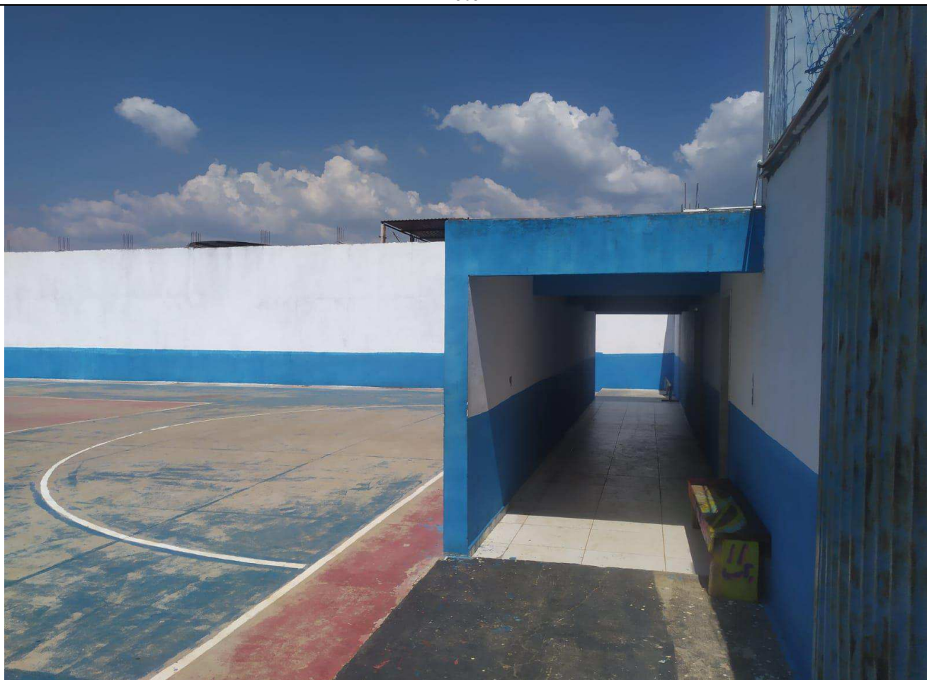
Pintura interna e externa - Data: 19/03/2024
