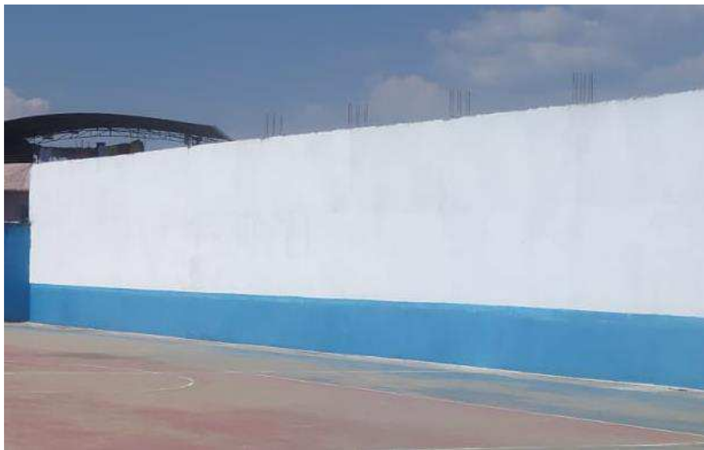
Parede da quadra - Data: 19/03/2024
