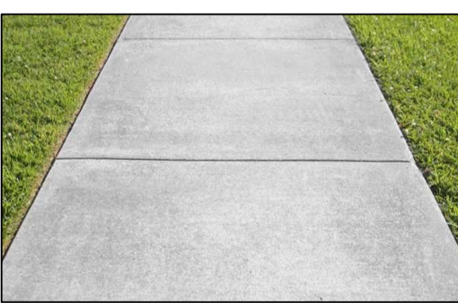
PISO DE CONCRETO LISO
