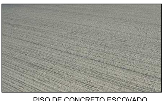
PISO DE CONCRETO ESCOVADO
